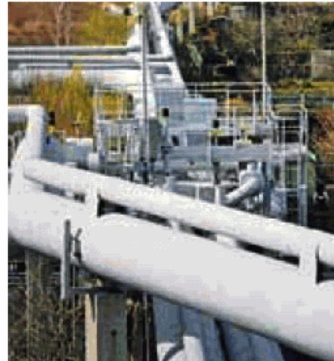
heizen. Das in der Zentrale auf eine Temperatur zwischen 80 und 130 Grad Celsius erwärmte Wasser fließt anschließend durch ein Leitungsnetz zu den angeschlossenen Gebäuden.
